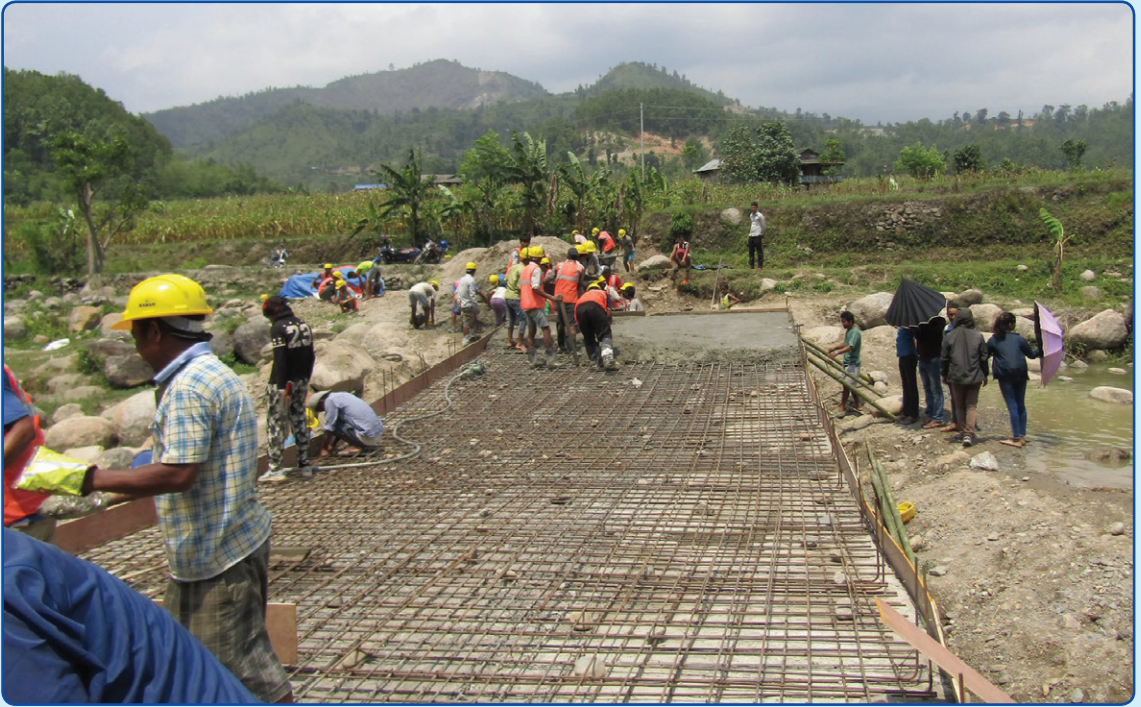
प्रधानमन्त्री रोजगार कार्यक्रम अन्तर्गत आ.व. २०७५/०७६ मा नेपाल सरकारबाट प्राप्त सशर्त बजेट अन्तर्गत भालुखोलामा निर्माणाधिन कच्चे ।
