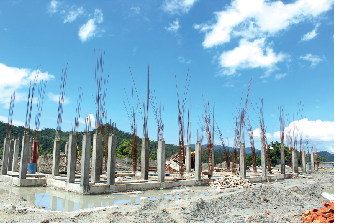
निर्माणाधीन पालिका भवन
